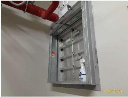
ระบบระบายอากาศของโถงลิฟต์ดับเพลิง
