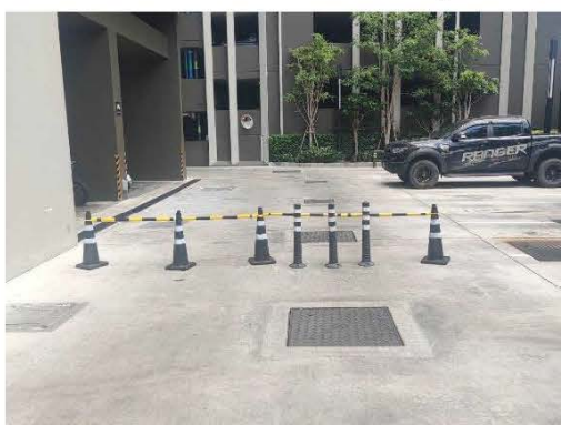
อุปกรณ์จำกัดการเข้าถึงก่อนมีการสูบน้ำออกจากระบบบำบัด
