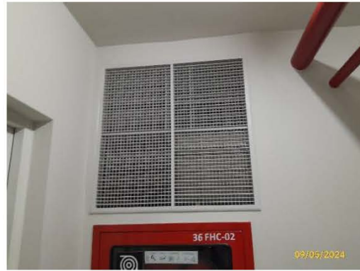
ระบบระบายอากาศของโถงลิฟต์ดับเพลิง
